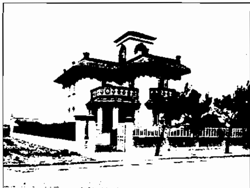
Figura 49.- Casa de Carrasco, construida en 1918 en la calle Potosí, demolida en 1950.
