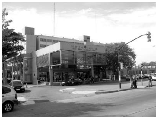
El Hospital Policial, en toma realizada el mismo día que las anteriores, en su estado actual.
