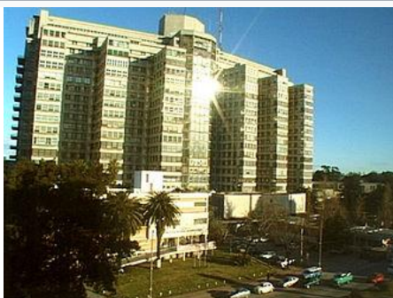
Hospital de Clínicas, vista frontal
