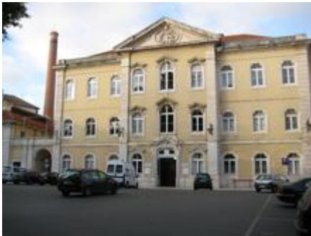
- Hospital Termal de Caldas da Rainha
