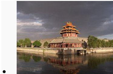
-Torre de la esquina noroeste.
