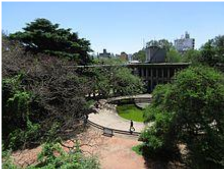
- Facultad de Arquitectura en Parque Rodó .
