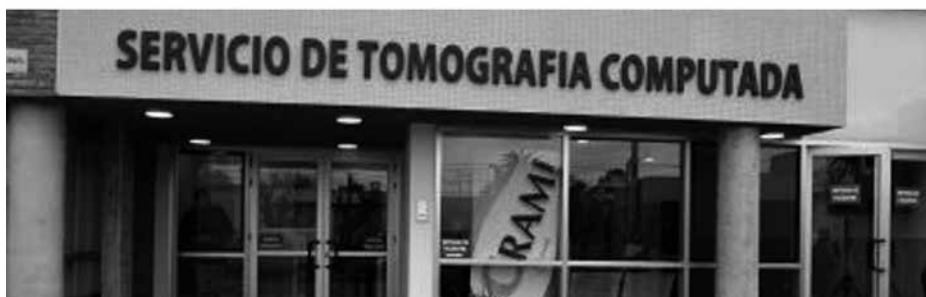
Figura 11: Junto al sanatorio Central de CRAMI inaugurado en 2010 (arriba), se edificó el local del tomógrafo propio en 2016 (abajo).
