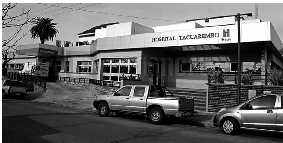
Figura 14: Hospital de Tacuarembó en la actualidad.
