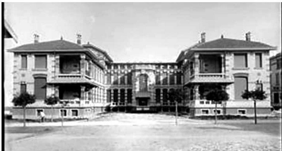
Figura 12: Pabellón de Ginecología.
