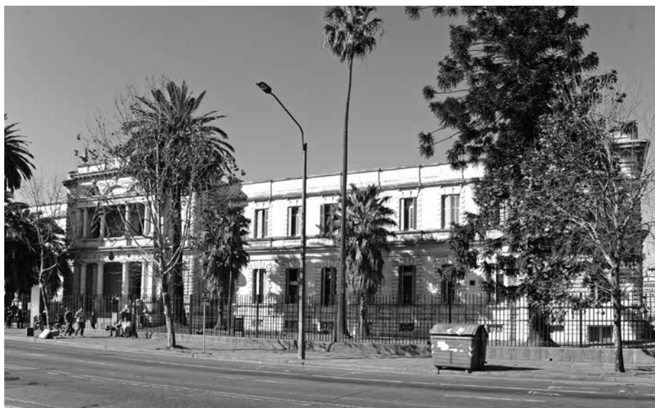
Figura 1: Hospital Central de las Fuerzas Armadas en la década del 80.
