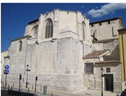
Lateral de la iglesia de San Gil , que da continuidad a la antigua muralla.
